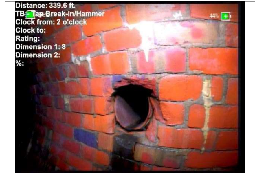
At: 339. TB - Tap Break-in/Hammer 6000061035 16 ft. 2/.
