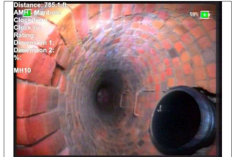
At: 785.2 ft. AMH - Manhole
