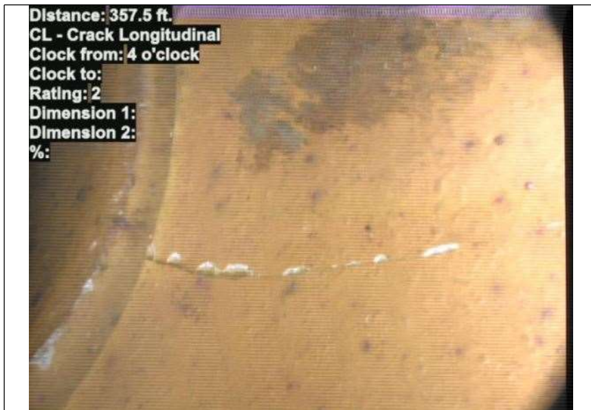
At: 357.5 ft. 4/. CL - Crack Longitudinal
